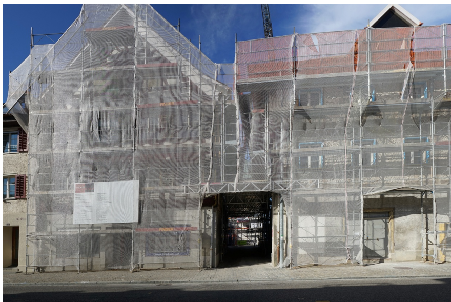
„Alte Schmitte“ und „Kaufhaus“ eingerüstet
