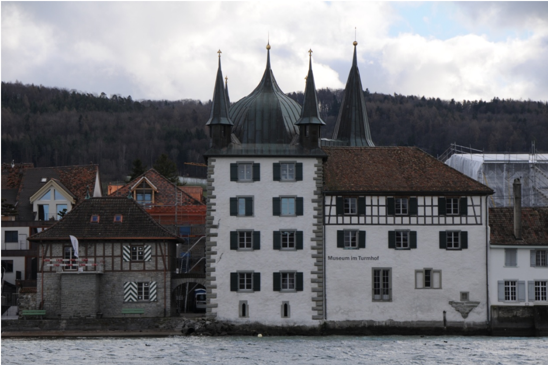
Turmhof nach der Renovation
