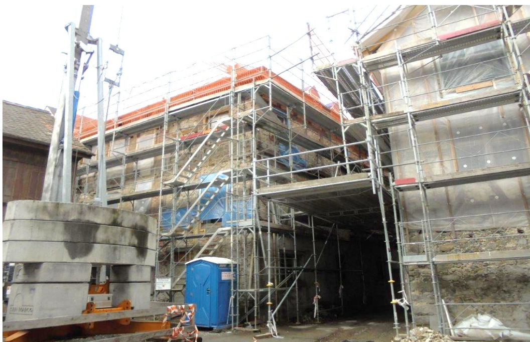
Die Baustelle vom Hof betrachtet
